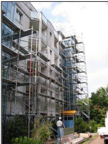
Die Fassade wird eingerüstet.
