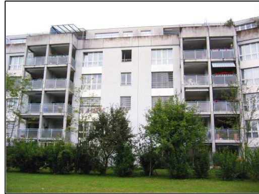
Konzepte erarbeiten für Terrassen-, Brüstungs- und Fassadensanierung.
