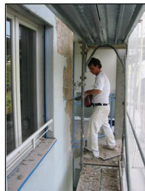
Kunststoffverputz entfernen, damit wasserdurchtränkte Fassade schneller trocknen kann.
